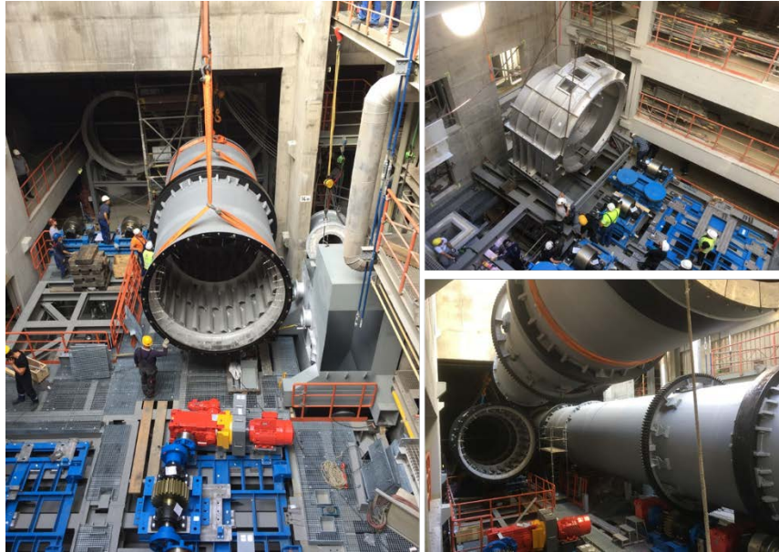
Bild 6: Drehrohröfenanlage während der Montage
